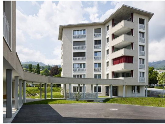
Alterswohnungen Blumenfeld, Schweiz Altstätten © Georg Aerni
