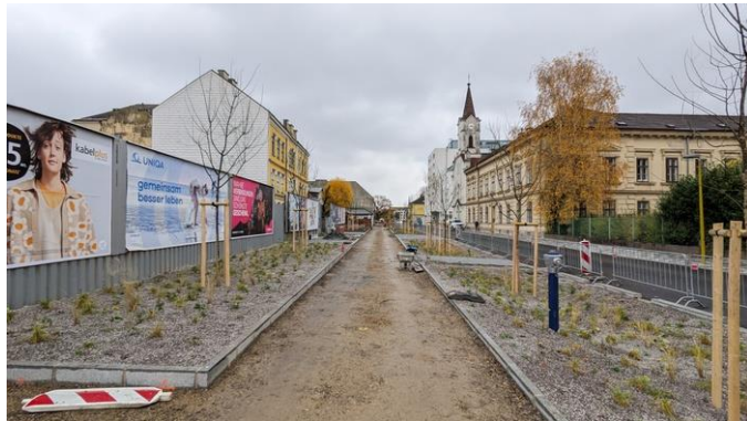
Baustellenfoto © Roland Barthofer
