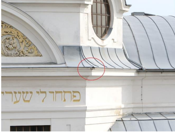
Ehemalige Synagoge St. Pölten vor der Sanierung mit vom Mauersegler genutzten Fassadenloch für seinen Nistplatz unterm Dach © Architekt Pfoser ZT
