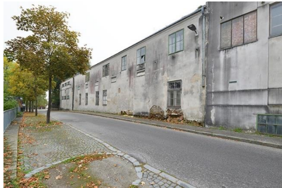
Ehem. Adensamer Textilfabrik, Groß-Siegharts © Sven Wuttej
