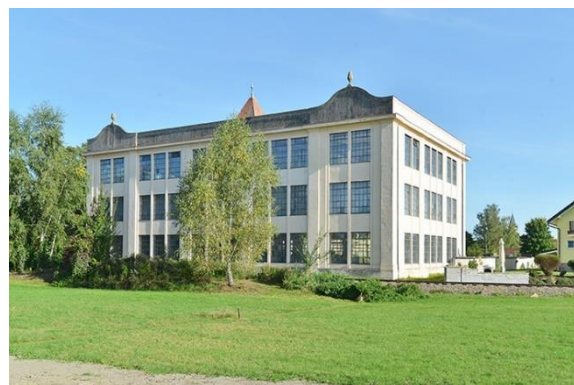
Ehem. Eisenberger Fabrik, Gmünd – © Sven Wuttej
