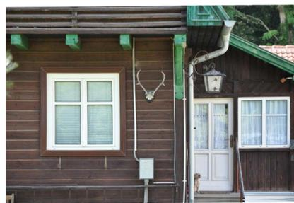
Selbst – an sich wünschenswerte – Sanierungen können an historischen Gebäuden Schaden anrichten: durch unangemessene Fassadendämmungen, Dachaufbauten, Fensterformatänderungen oder etwa Rollladeneinbauten. Sensibilität im Umgang mit dem Altbestand kann selten vorausgesetzt werden – wie das Beispiel eines rustikalen Holzhauses zeigt, das der Eigentümer mit Kunststoffen ausstatten ließ ...
