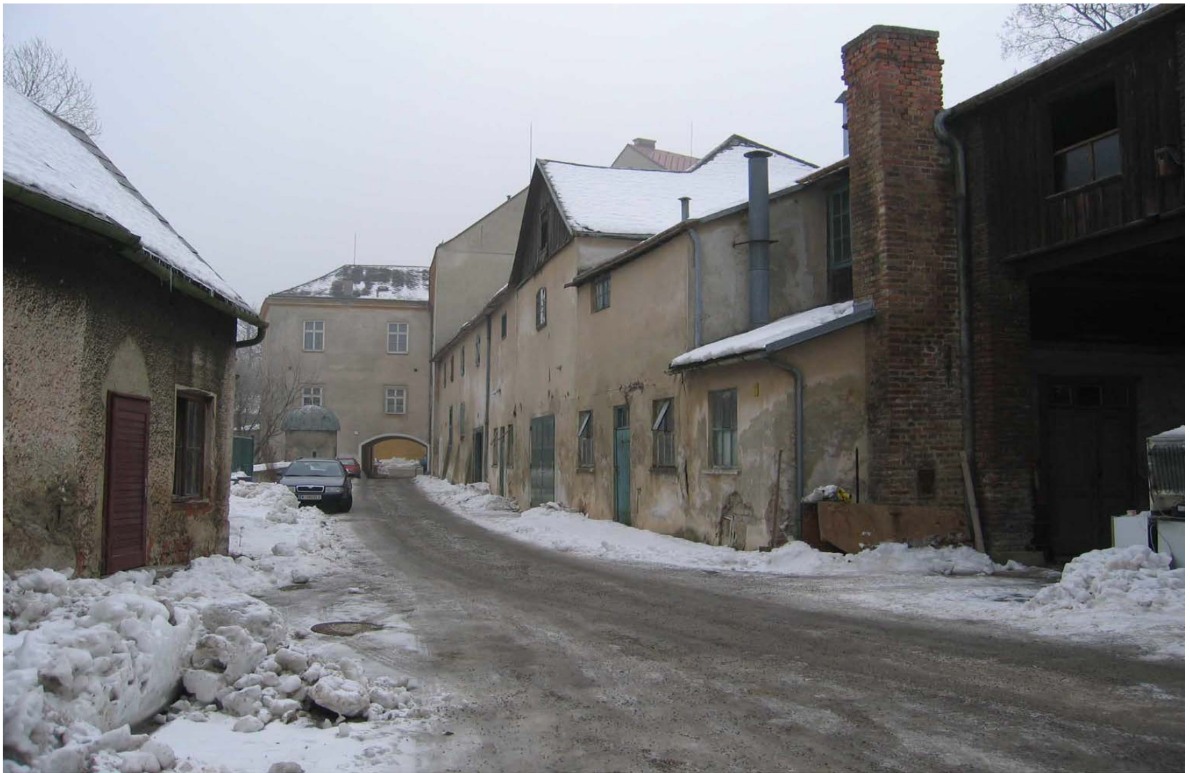
abzubrechender "Wirtschaftstrakt" von Nord-Westen (an seiner Stelle soll Neubau entstehen)
