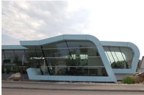
Erweiterung der Firma Neidhart – Loosdorf
